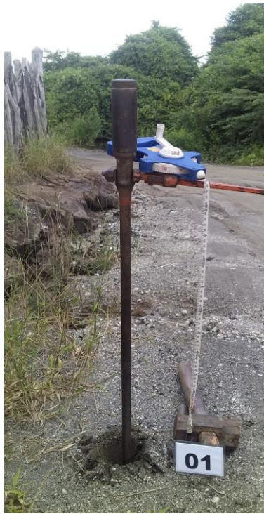
Foto 01 – Sondagem em S 01 com profundidade de 0,95m.
