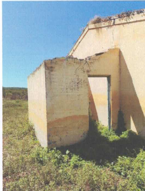
Figura 01 – Área a ser demolida.
