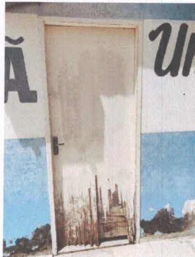
Figura 02 – Foto porta fachada frontal
