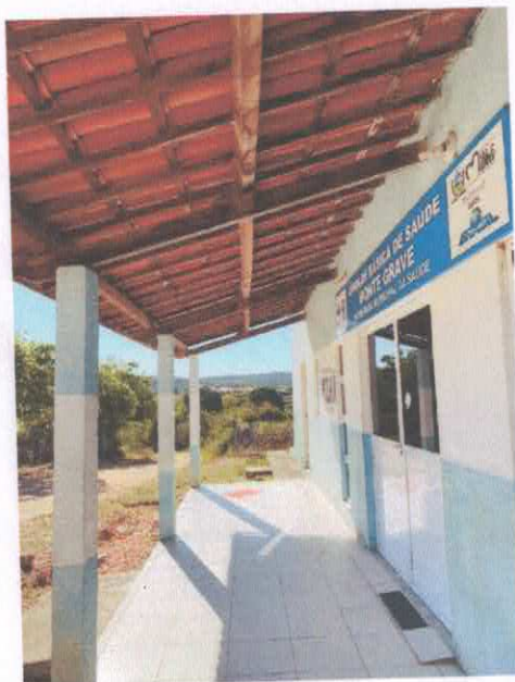
Figura 02 – Foto fachada frontal, estrutura madeira a ser envernizada.
