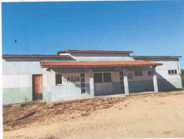
Figura 01- Foto terreno desnivelado.
